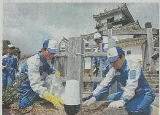
天守閣近くの木柵のシロアリ防除をするスタッフ＝掛川市の掛川城で
