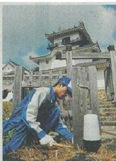
天守閣前の木柵でシロアリ防除作業をする社員＝掛川市内
